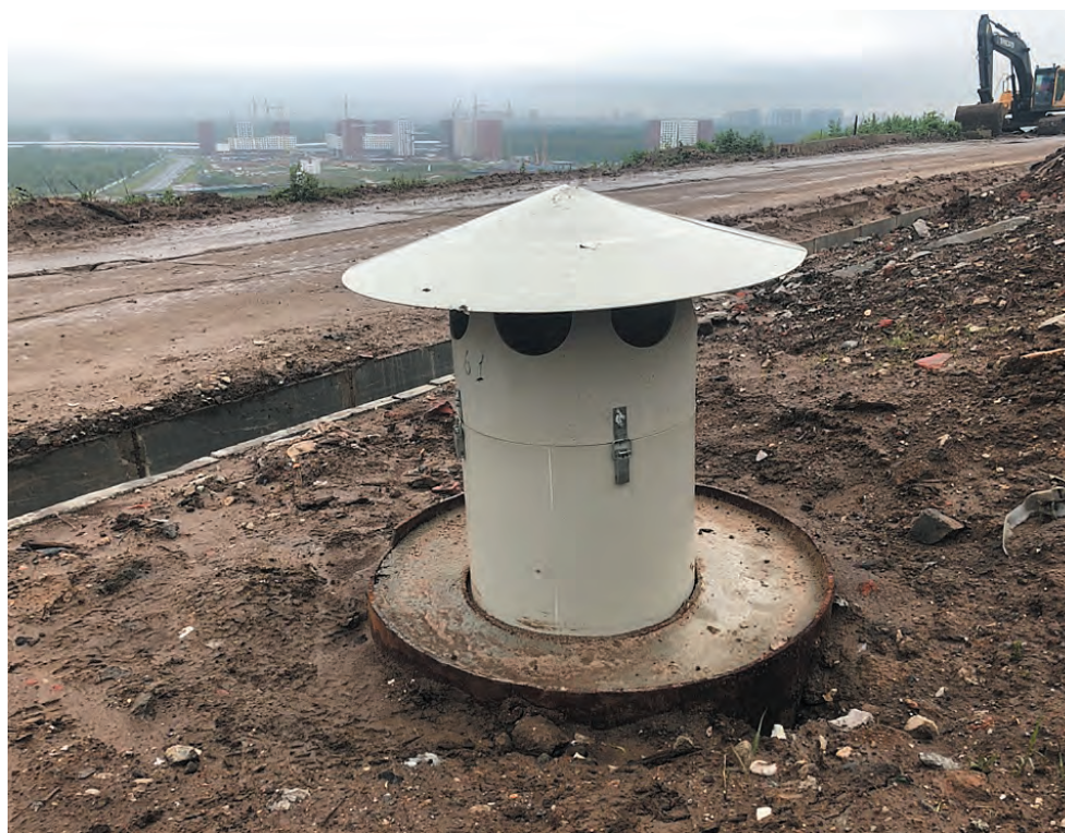
Рис. 2. Фильтр УФЗ 300 для пассивной дегазации полигона ТКО
