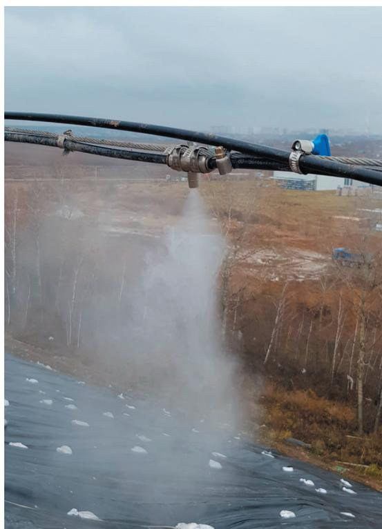
Рис. 1. Распыляющая форсунка
